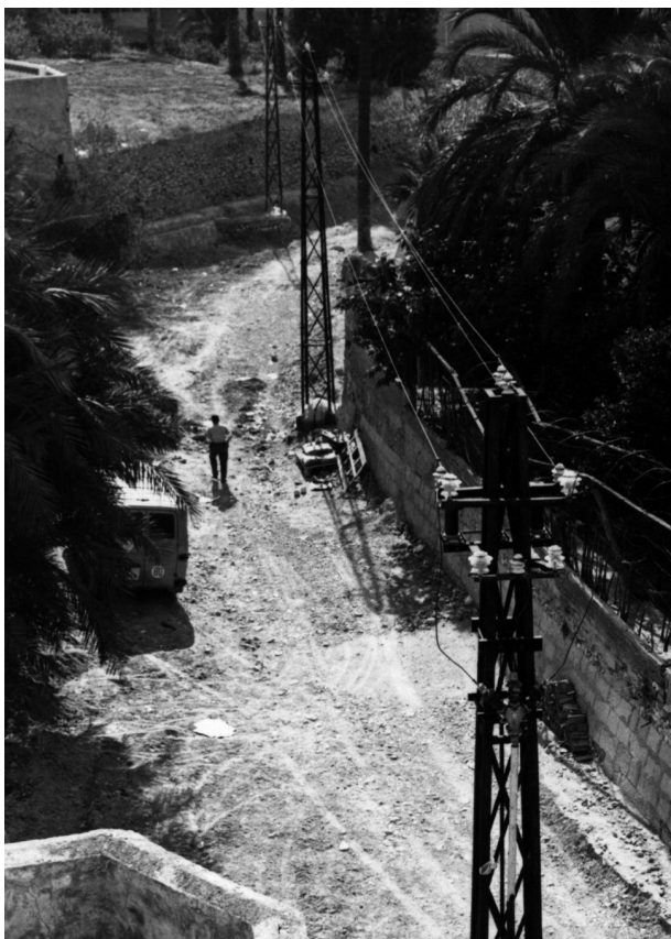
Línea eléctrica aérea sobre apoyos en celosía, en el cauce de la rambla "El Castelar", de Crevillent (Autor: Fotos Pepe, mediados del siglo XX).
